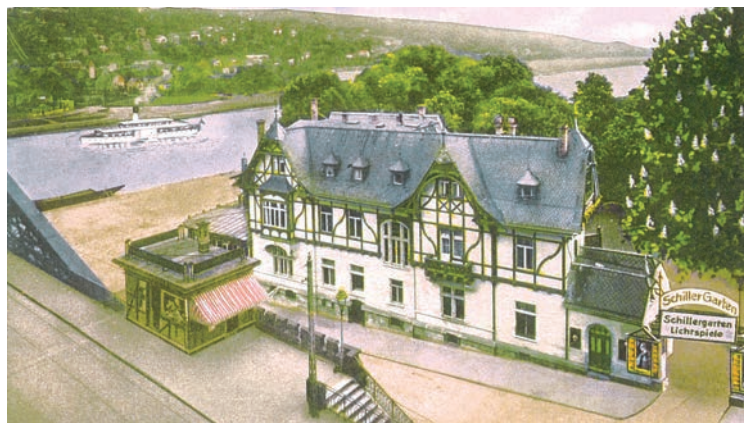
SchillerGarten mit Brückenzollhäuschen
