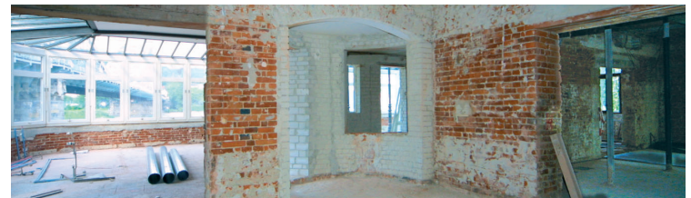
Anfang Juni 2004 – Blick vom heutigen Eckzimmer in den Wintergarten
