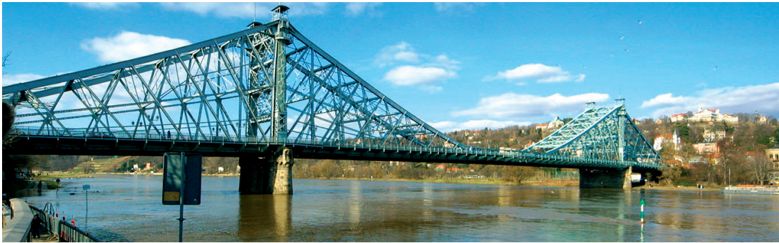
Das „Blaue Wunder“ mit einer Spannweite von 141,5 m ist eine ingenieurtechnische Meisterleistung
