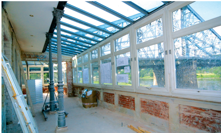
Juni 2004 – Der Wintergarten im Bauzustand am Anfang der Arbeiten
