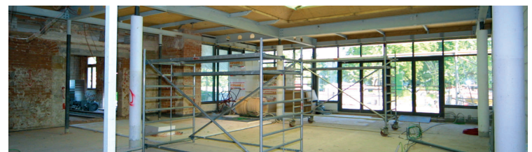
Anfang Juni 2004 – Der zukünftige Schankraum noch nicht erkennbar
