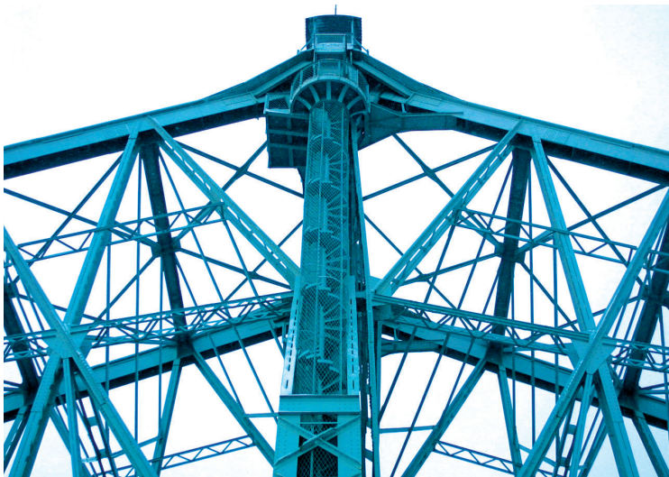
Die Konstruktion mit ca. 100.000 Nieten und 3200 Tonnen Stahl
